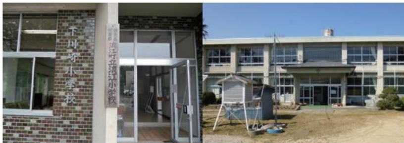
(左、中) 福島県二本松市で再開した浪江小学校仮校舎
