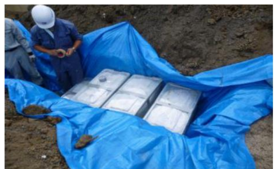
(右) 除染で出たごみをそのまま敷地に穴を掘って埋める福島市の「除染」
