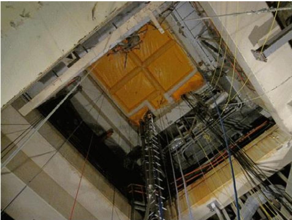
図一6 バルーン（覆い）取り付け時の状態
