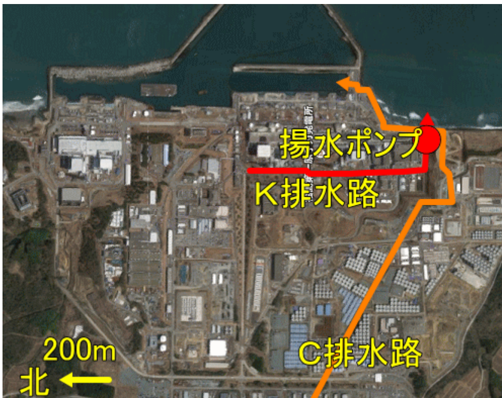
図一 1 2 K排水路
