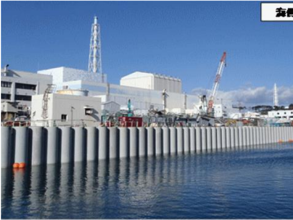
図一 1 1 海側遮水壁
