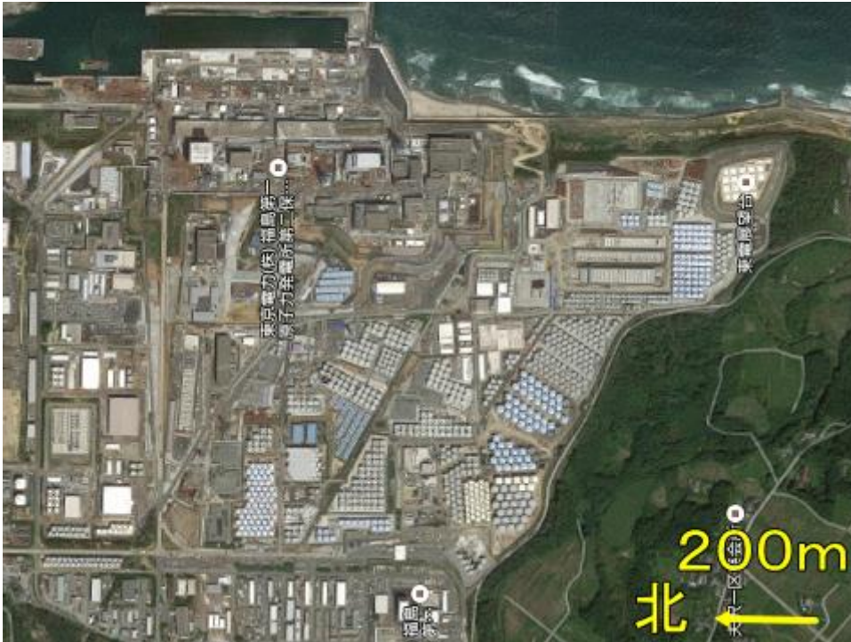
図一 9 汚染水タンクで一杯になった福島第一原発の敷地
