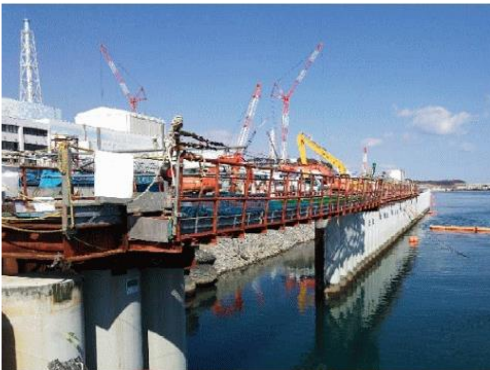
図一 1 2 海側遮水壁
