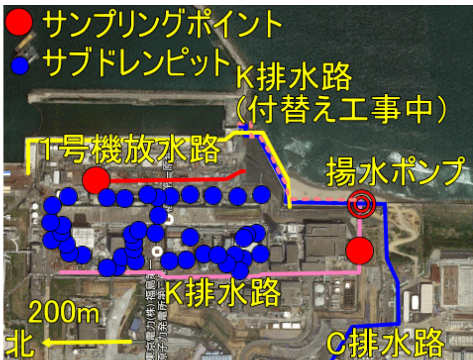
図一1 1号機放水路と周辺
