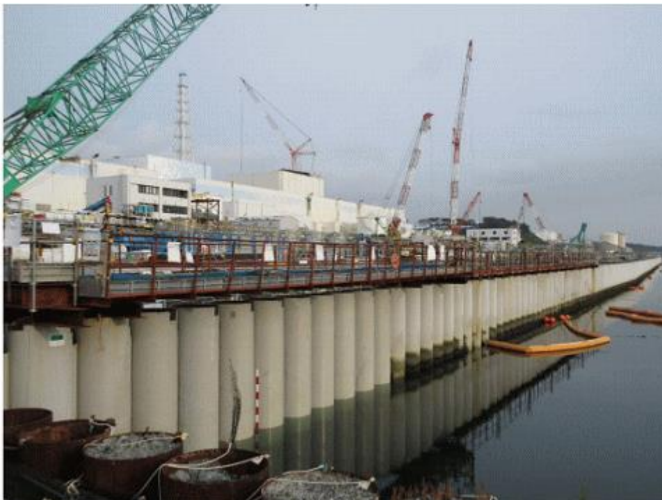
図一八 打設工事が完了した海側遮水壁
